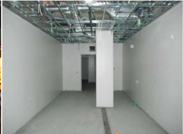
3階小動物室(1) 天井LGS組・壁塗装
