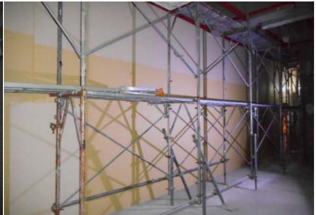
1階通路(1) 耐火壁ボード張り
