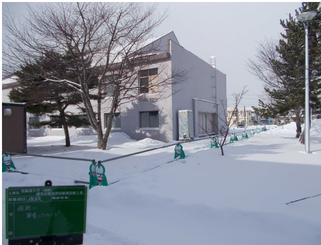
仮囲い設置完了
