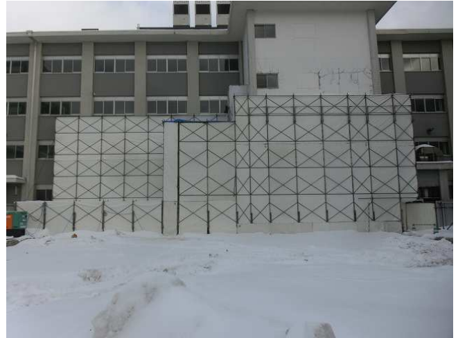
改修用外部足場組立
