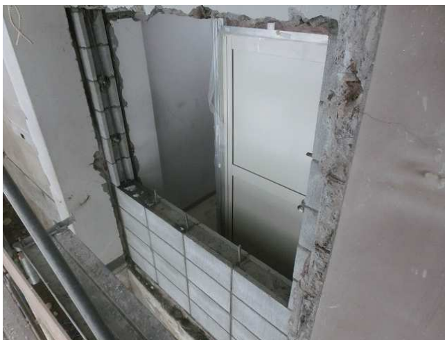
外壁コンクリートブロック積み (1階)
