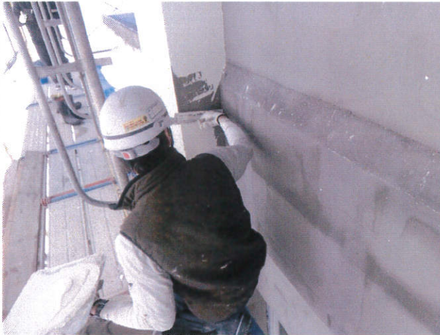
湿式外断熱仕上施工
