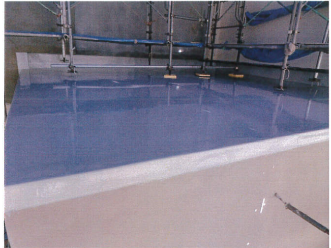
ウレタン塗膜防水施工
