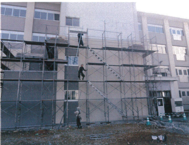
改修用外部足場解体
