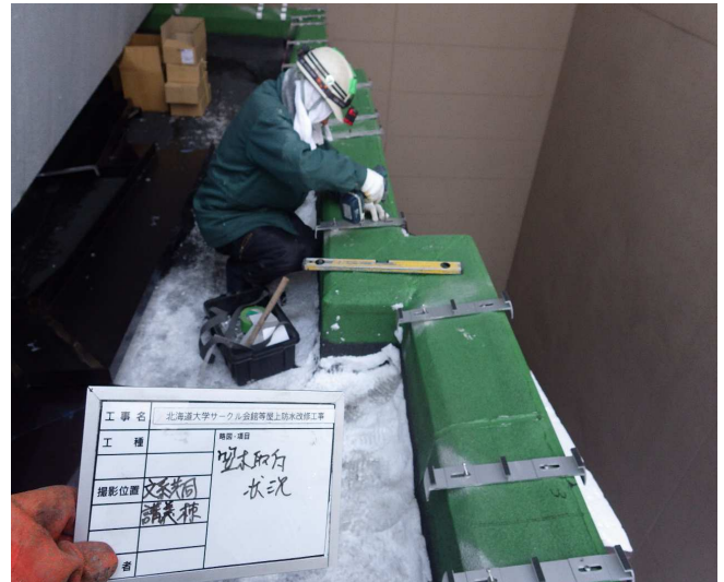
文系共同講義棟防水押え金物取付工事中
