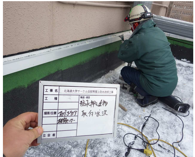
スラブ・ユーラシア研究棟防水押え金物工事中
