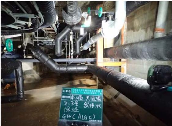
共同溝内給水配管(事務局系統)保温状況
