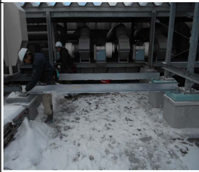
屋上機械基礎設鉄骨架台工事
