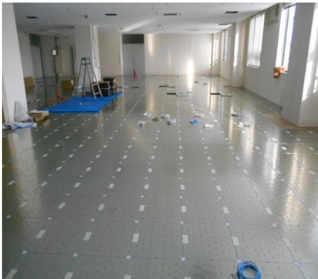
4階OA設置工事
