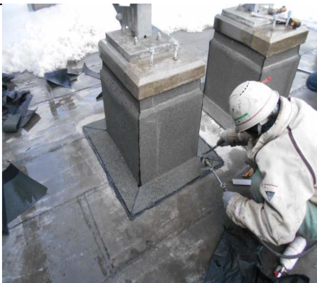
屋上機械基礎防水工事
