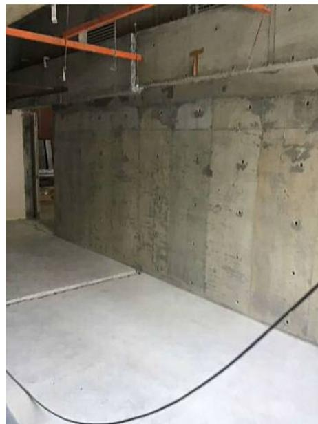
1階 耐震壁コン打設・グラウト注入完了
