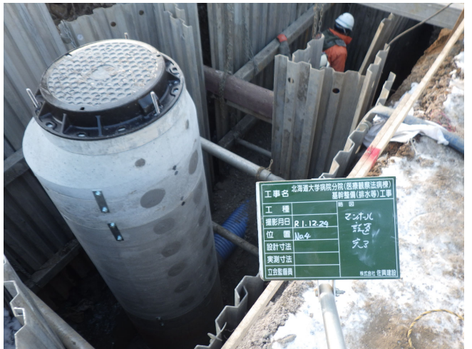
マンホール設置
