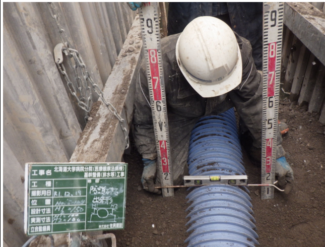
防護碎石（高さ）
