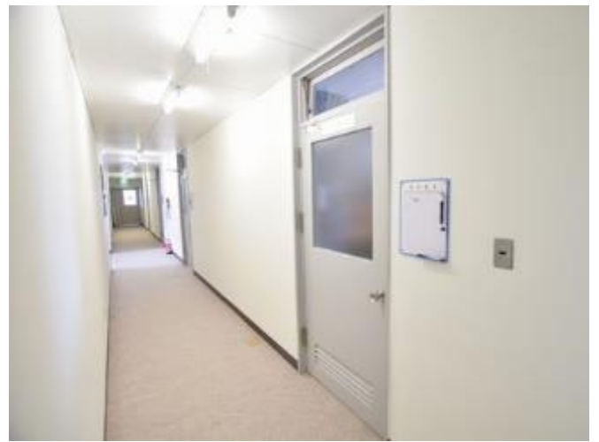
1階廊下 塗装完了状況
