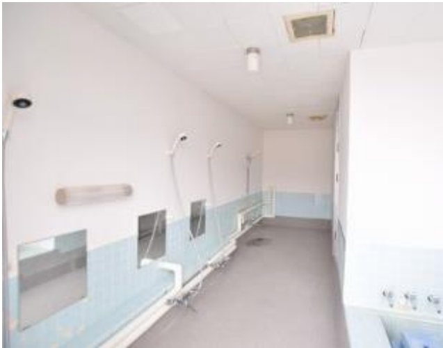
浴室 塗装及び床改修 完了状況
