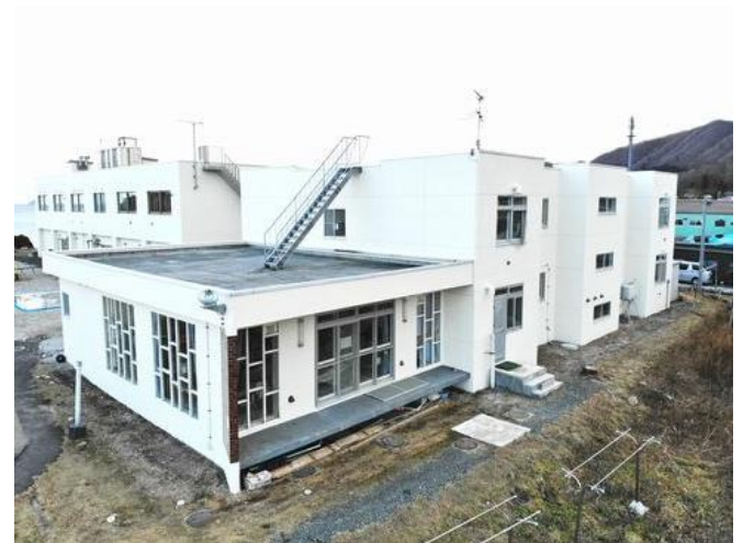
外部改修完了状況（西面）
