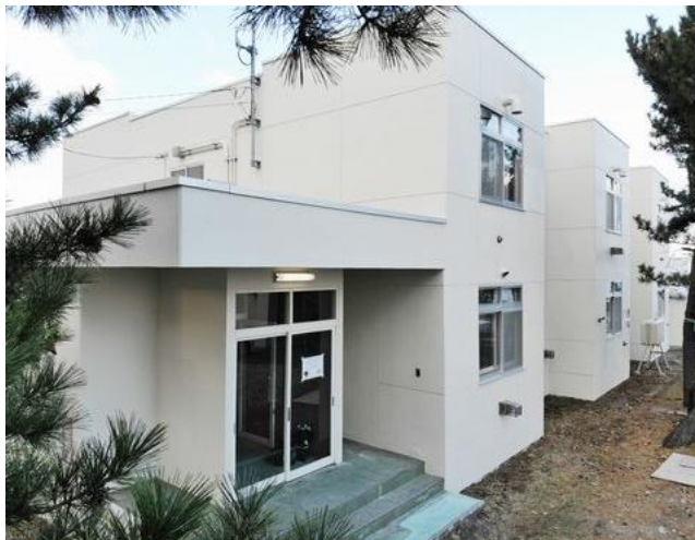
外部改修完了状況（東面）
