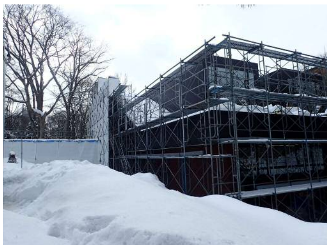
外部足場撤去中
