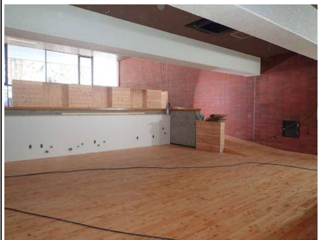
1階レストラン フローリング貼り
