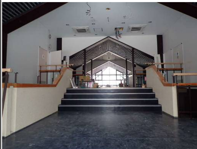
3階ロビー、ラウンジ床貼り完了
