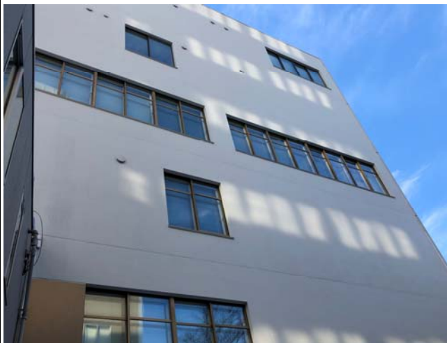
A棟北面足場解体後状況
