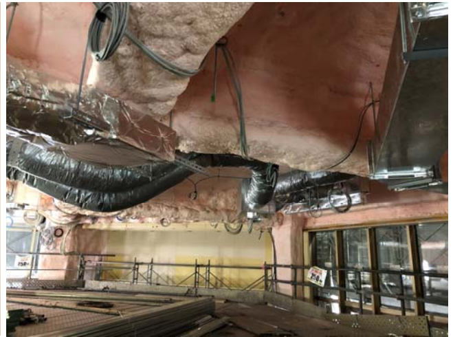
B棟2階内装仕上状況
