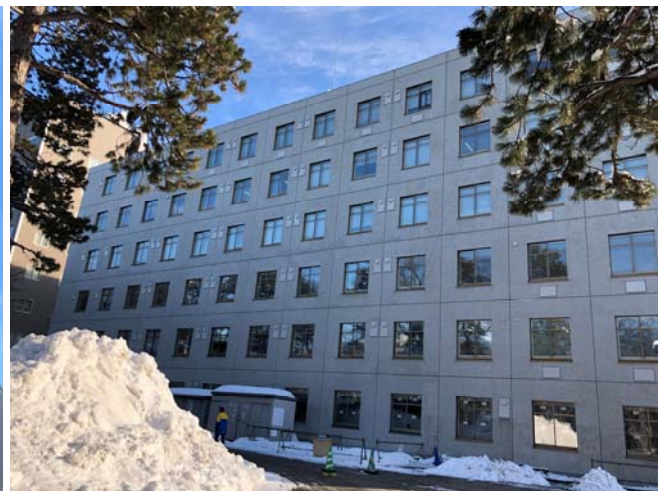
A棟西面足場解体後状況
