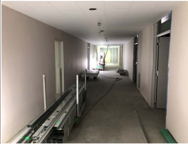
A棟1階内装仕上状況
