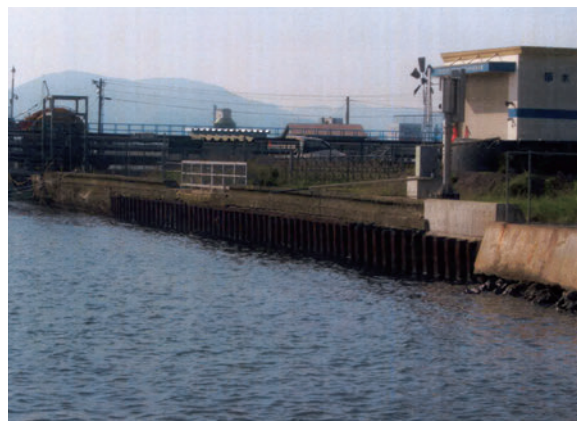
②護岸の状況
