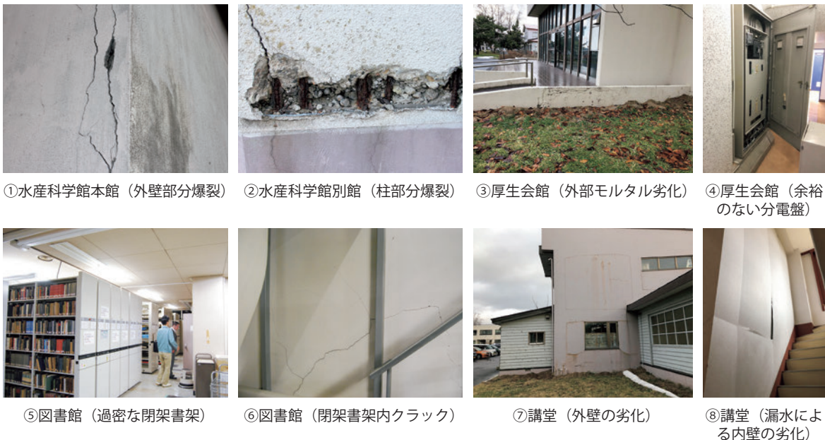
写真3-3：施設の老朽化状況
