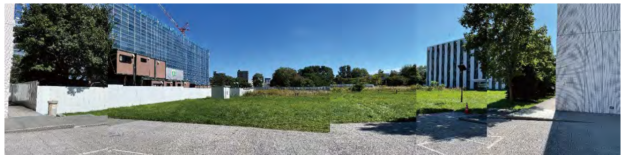
西側創成科学研究棟前より広場全体を望む
