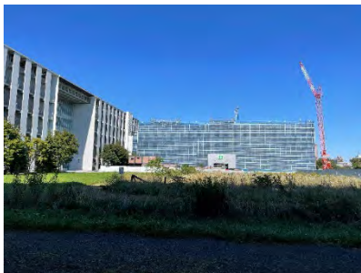
計画地南側より北方向 工事中の ICreDD 新棟を望む
